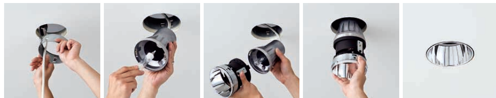
本体を仕上げた天井の穴に挿入する。 ランプを装着する。 光源パーツをセットする。 灯具全体を挿入する。 完成
